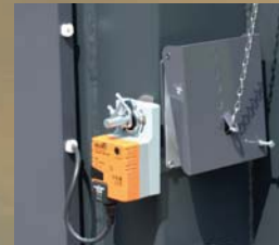
Die Regelung von Abgastemperatur und Kesselleistung
